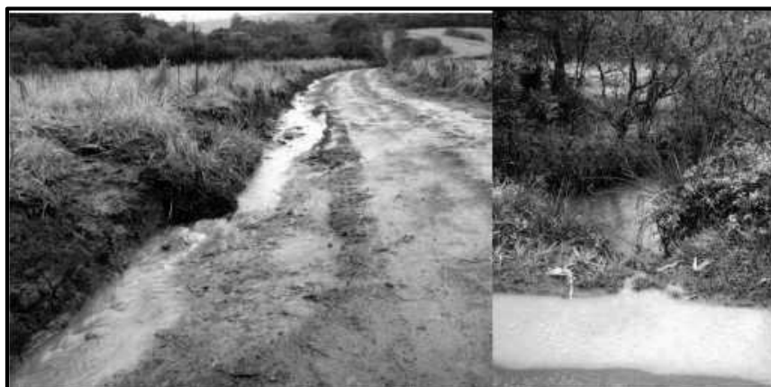
Figura 13. Escoamento superficial em estrada rural e entrada de sedimento no córrego, na BHRG. (09/04/2010) – Fonte: Thomaz et al. (2014)
