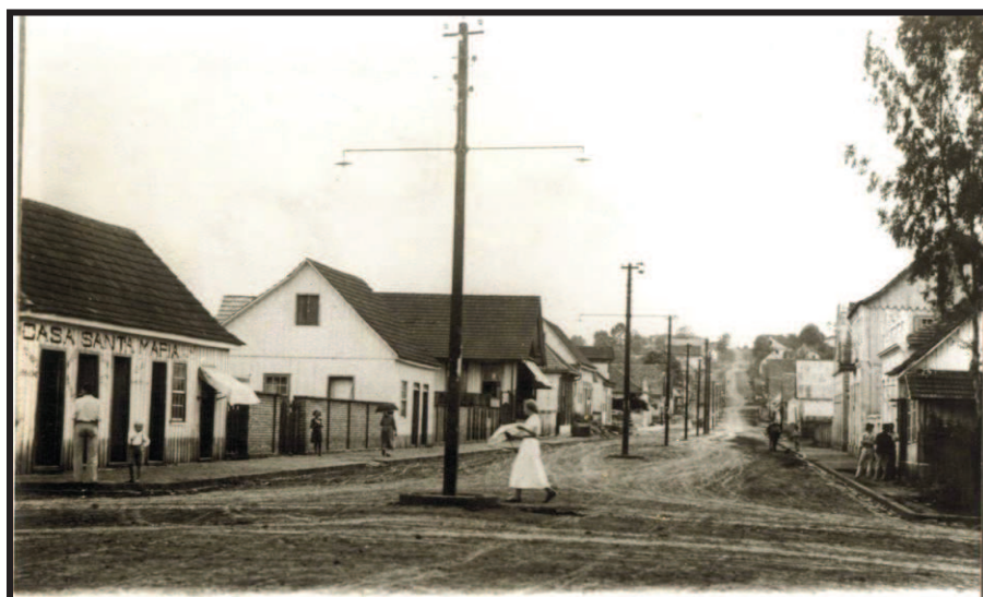
Figura 7: Rua 15 de novembro esquina com a Rua da Liberdade
