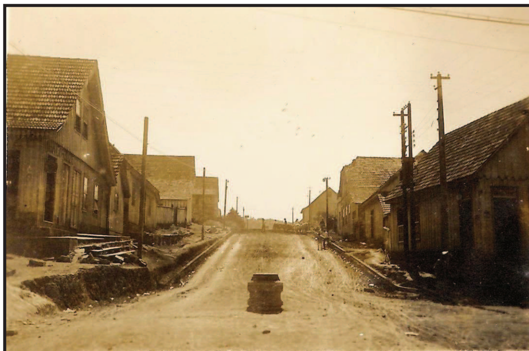
Figura 5: Preliminares da pavimentação da Rua Coronel Emilio Gomes.
