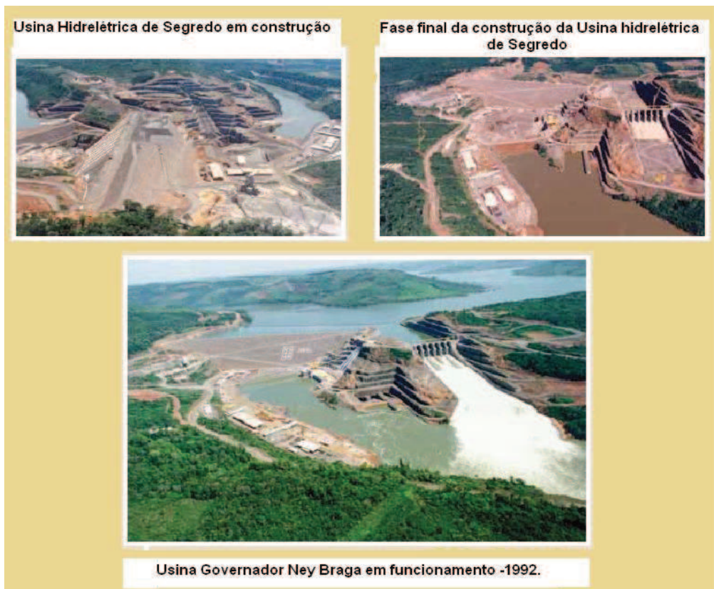
Figura 1- Vista aérea da Usina de Segredo.
