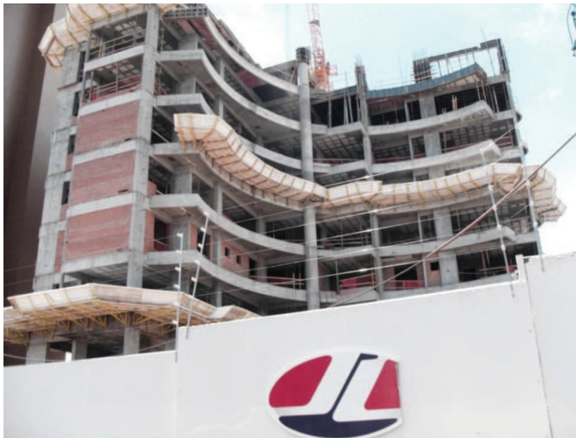
Figura 23 - Cascavel: construção do Edifício Excellence
