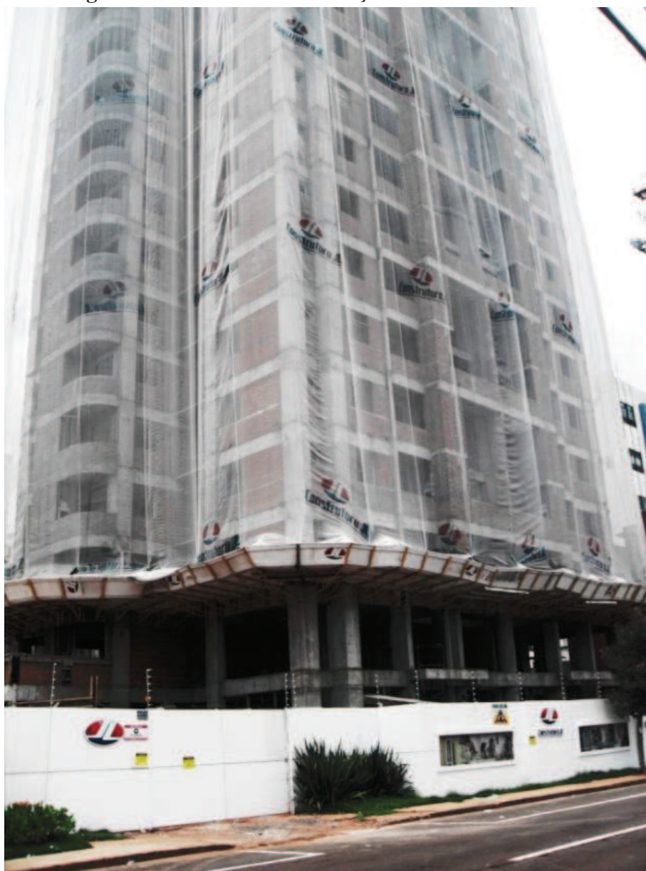
Figura 22 - Cascavel: Construção do Edifício Alto Leblon
