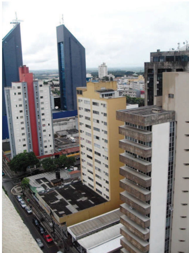
Figura 21 - Verticalização no Centro de Cascavel
