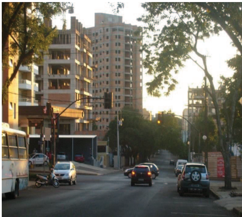
Figura 38 - Cascavel: edifícios em construção no centro 2008
