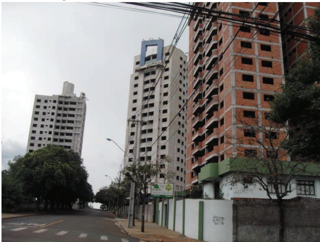
Figura 35 - Edifícios em construção na área central
