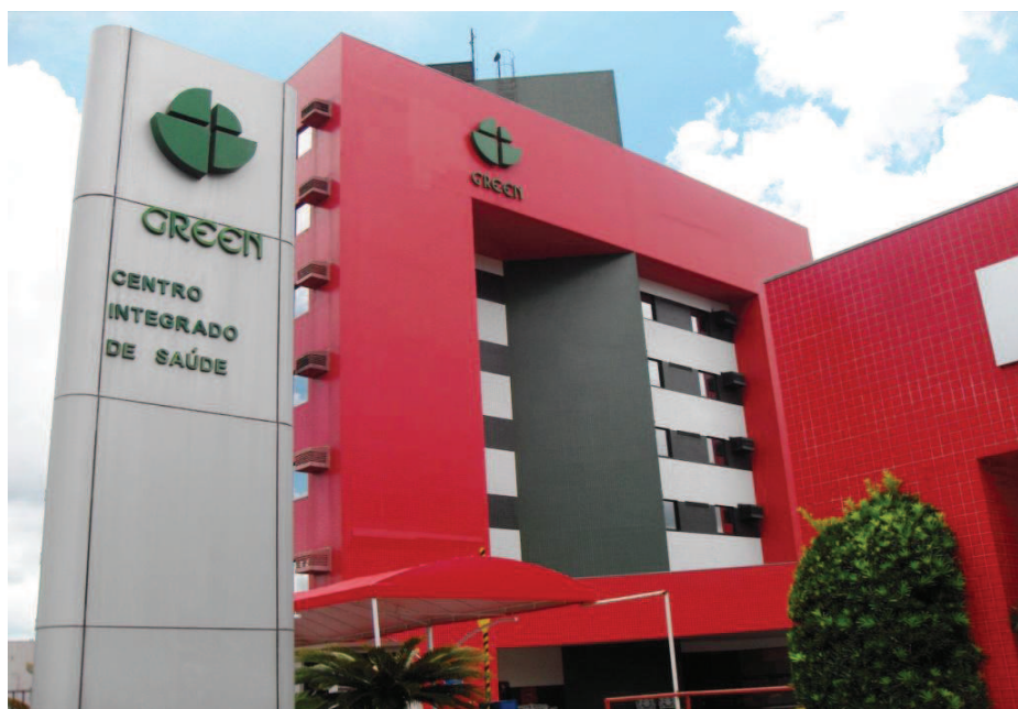
Figura 31 - Cascavel: Edifício Green
