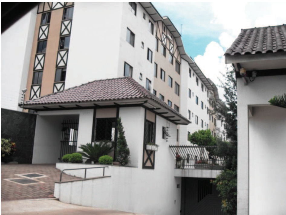
Figura 33 - Cascavel: Condomínio Residencial Nuremberg
