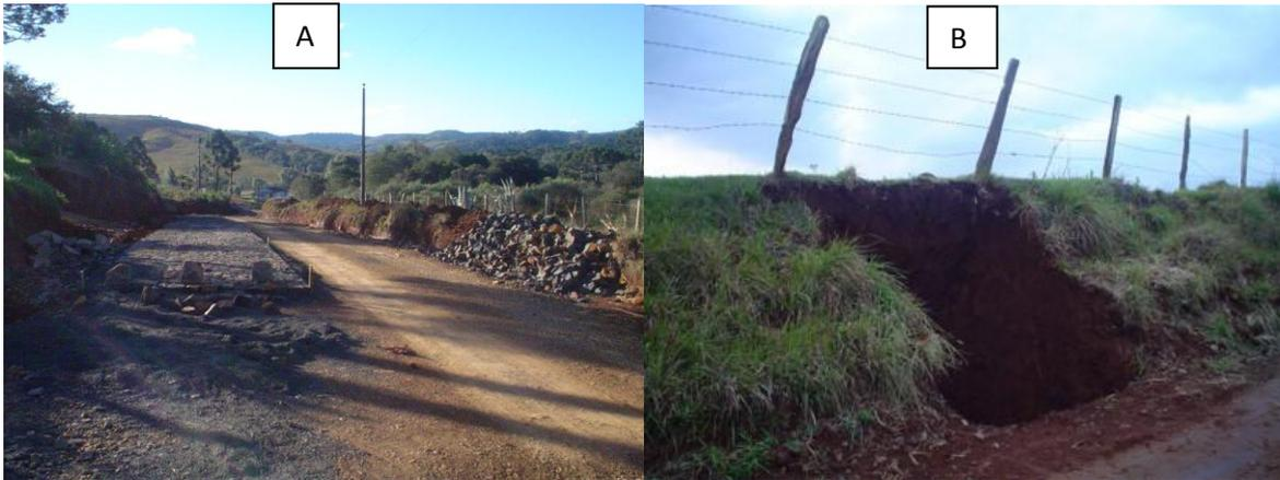
**Figura 8-** Em A, estradas rurais como fonte e transferência de sedimentos em eventos pluviométricos. Exemplo de trecho que necessita da implantação das caixas de contenção. Em B estrada com caixa de contenção.
