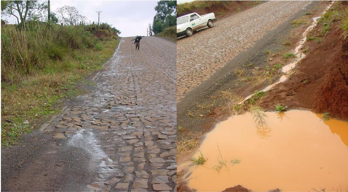
**Figura 11-** Estradas com pedra irregular para diminuir os impactos nas estradas e a produção de sedimentos e drenagem lateral direcionando o fluxo da água para as caixas de contenção
