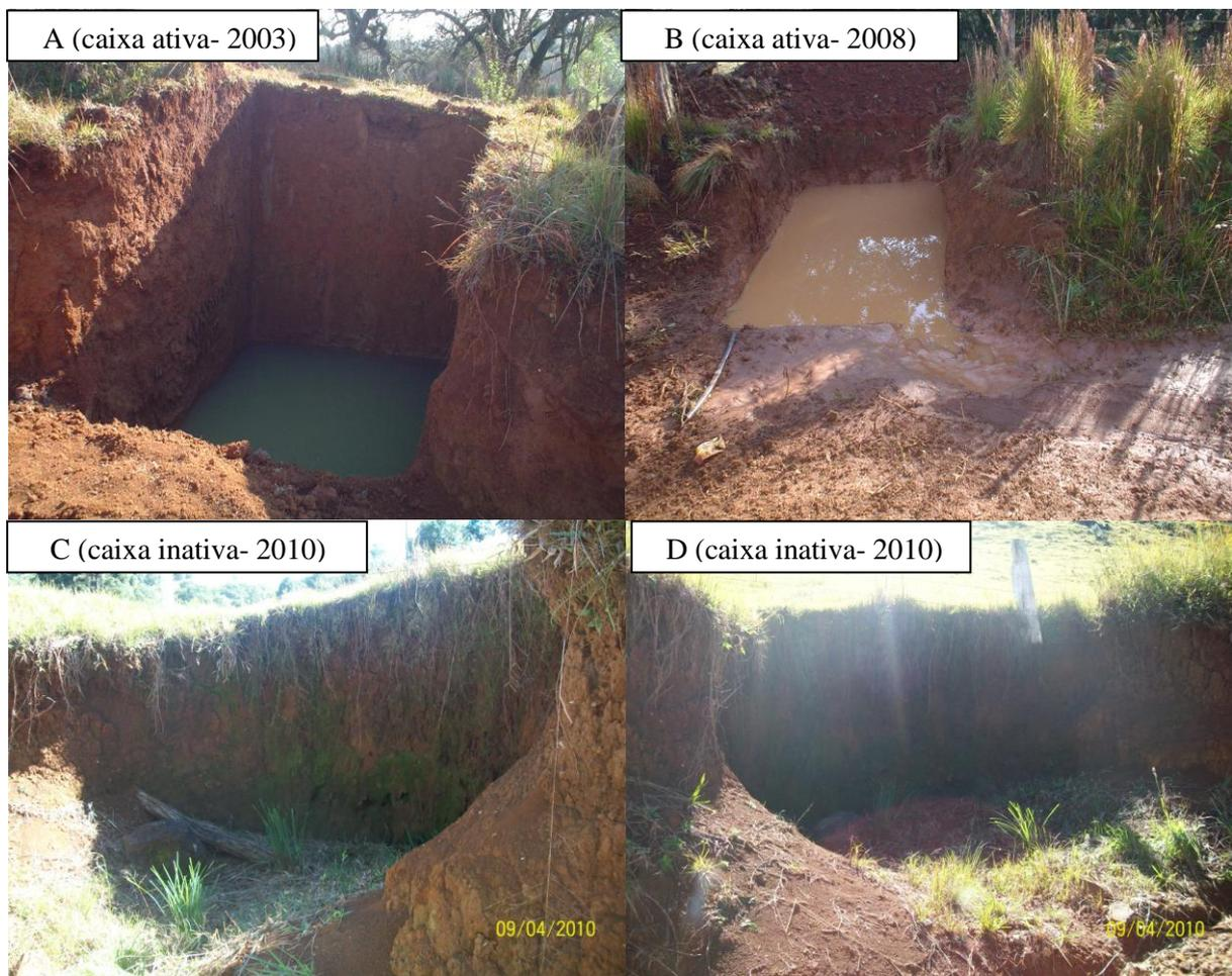
**Figura 9-** Medidas de controle de sedimentos (caixas de contenção). Em A, caixa ativa no estado inicial em 2003; em B caixa ativa em 2008; em C e D caixa inativa em 2010
