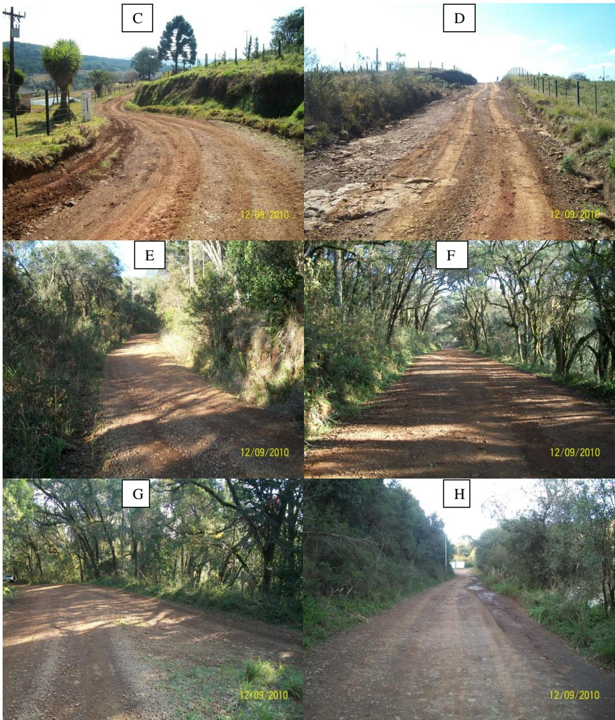
**Figura 5** – Continuação: em C, ravina no sentido transversal; em D, forte ravinamento, sem dissipadores de energia; em E e F, pouca presença de ravinas; em G, estrada primária e estrada secundária; em H, estrada na margem direita do Rio das Pedras com fluxo subsuperficial.
