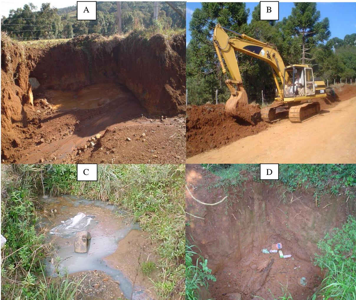
**Figura 12-** Em A caixa destruída com a força da enxurrada, em B retroescavadeira utilizada para a construção das caixas, em C e D lixo trazido pela enxurrada e/ou depositado nas caixas de contenção
