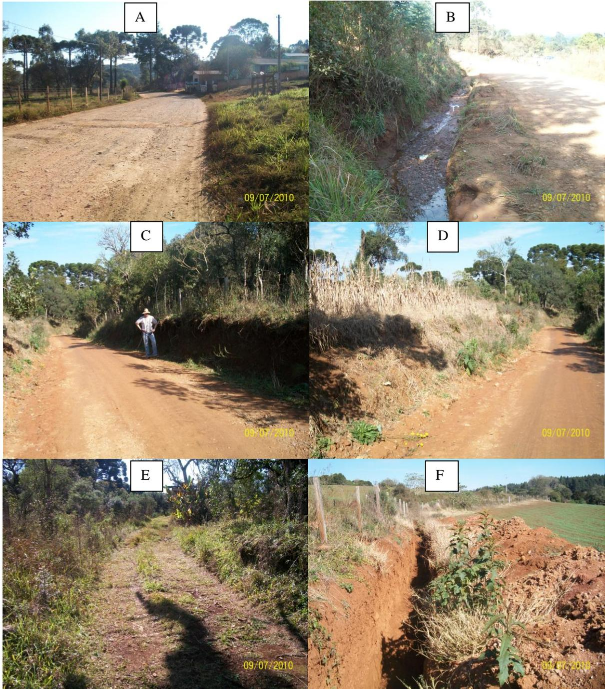
**Figura 3-** Características das estradas na bacia hidrográfica do Rio das Pedras do setor 1. Em A, estrada primária; em B, ravina com 120 m de comprimento interceptando o fluxo subsuperficial; em C, barranco em repouso; em D, barranco com vegetação exposta à luz do sol durante maior período do dia; em E, caminho interno com vegetação; em F, medida de controle de drenagem construída pelo proprietário.
