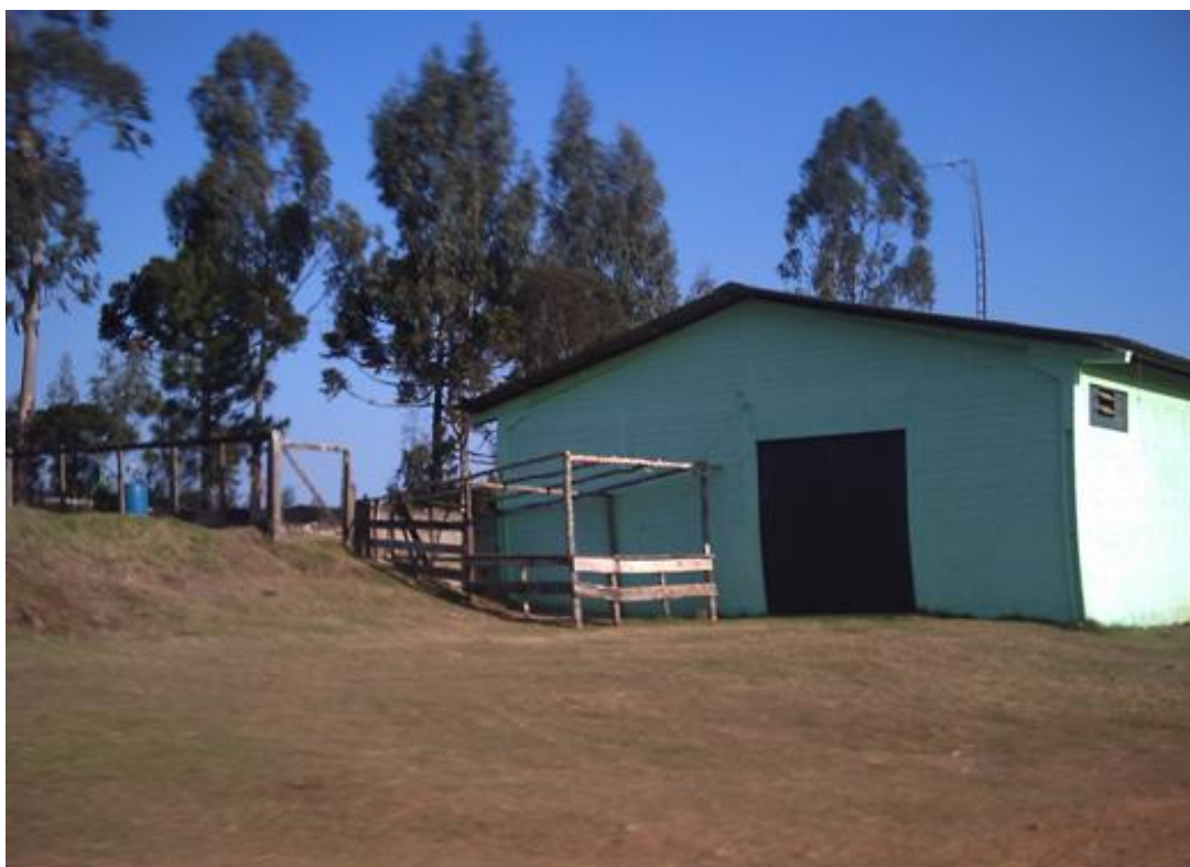
FIGURA 24: Sede da associação de moradores da comunidade de Faxinal do Posto FONTE: LIMA, L.S. de. (2010).
