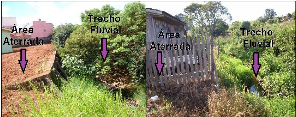
Figura 5.15 – Trecho fluvial com alteração da planície por terraplanagem Foto do autor (março de 2011)
