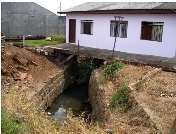
Figura 5.63 – Moradia construída sobre tributário do Arroio Carro Quebrado
