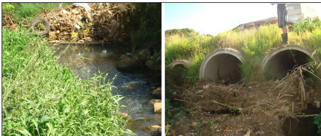
Figura 5.35 – Seção transversal aberta e fechada com resíduos tecnogênico Foto do autor (março de 2011)
