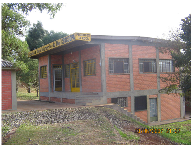
Figura 1. Foto externa da CERCCOPA (Guarapuava – PR)
