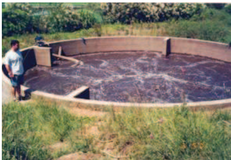
FIGURA 9. TANQUE DE TRATAMENTO POR LODO ATIVADO (Fonte: http://www.finep.gov.br/prosab/3_esgoto_ufrgs )
