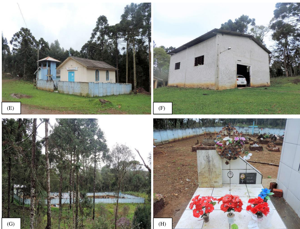
Fotografia 10 - Infraestrutura da comunidade Quarteirão dos Stresser
