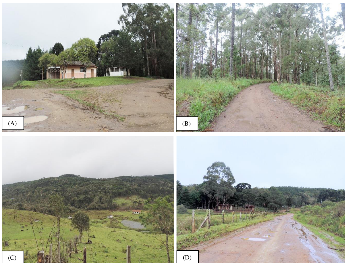
Fotografia 11 - Infraestrutura da Comunidade Queimadas
