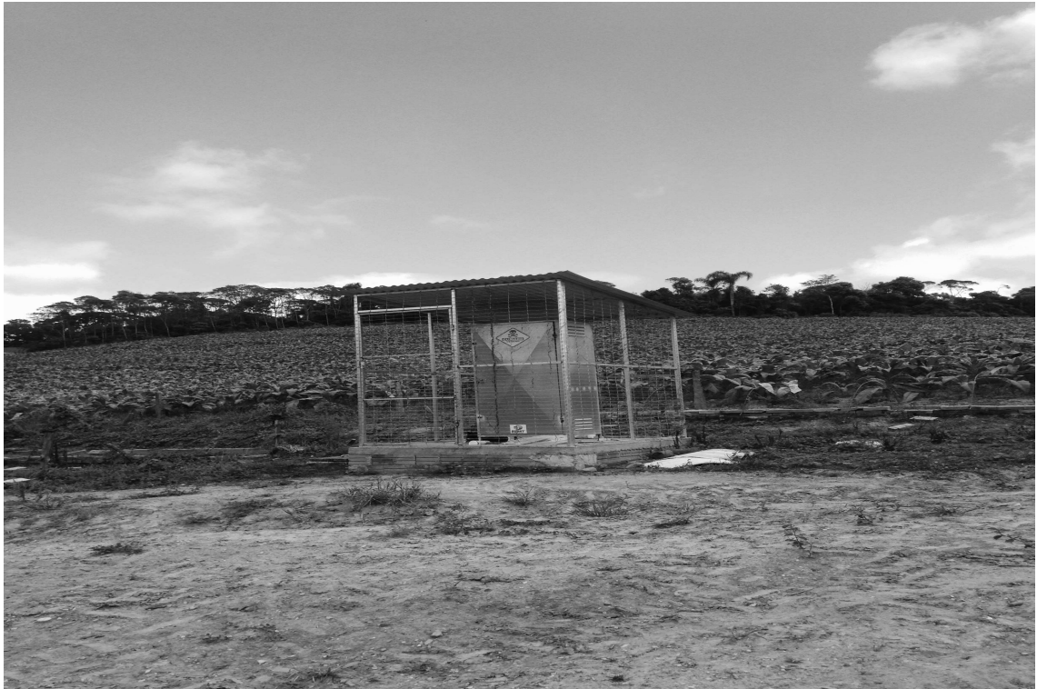
Figura 5 – Depósito de agrotóxicos
