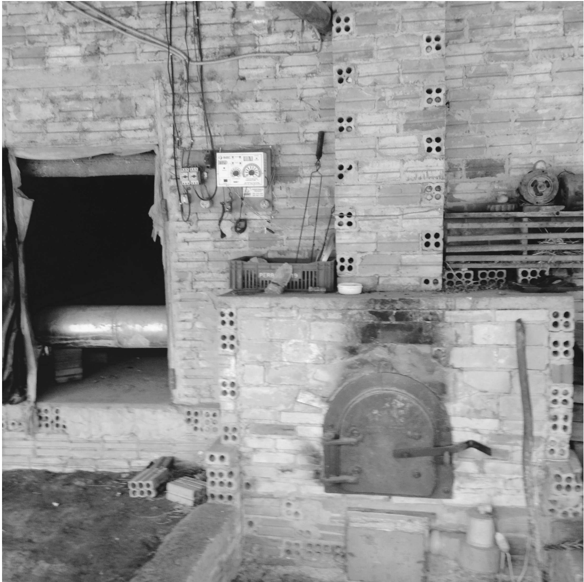
Figura 9 – Forno e motor de controle da temperatura da estufa de fumo
