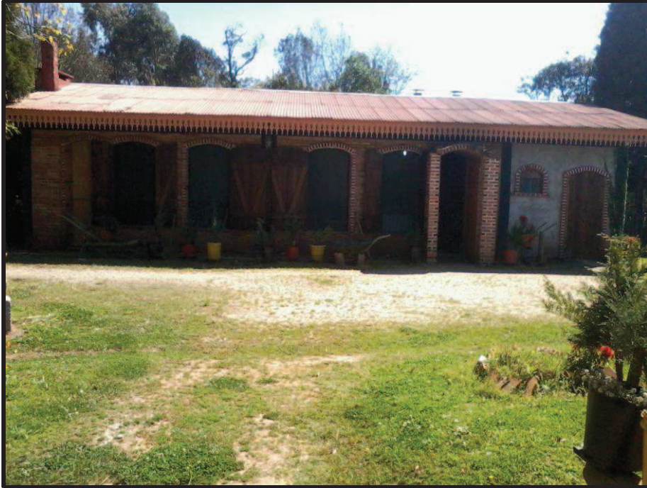
Imagem 18 – Fachada Restaurante Bauernhaus Fonte: acervo da autora, 2014.
