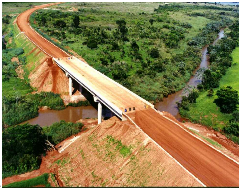
Imagem 16 – Ponte em processo final de construção.
