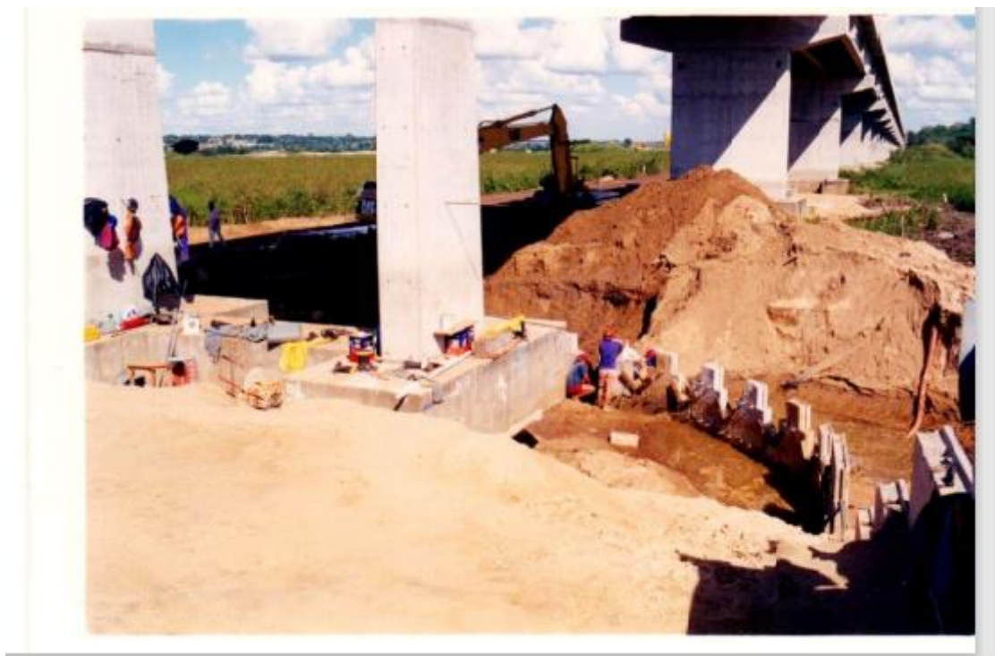
Imagem 21 – Obra na ilha bandeirantes.
