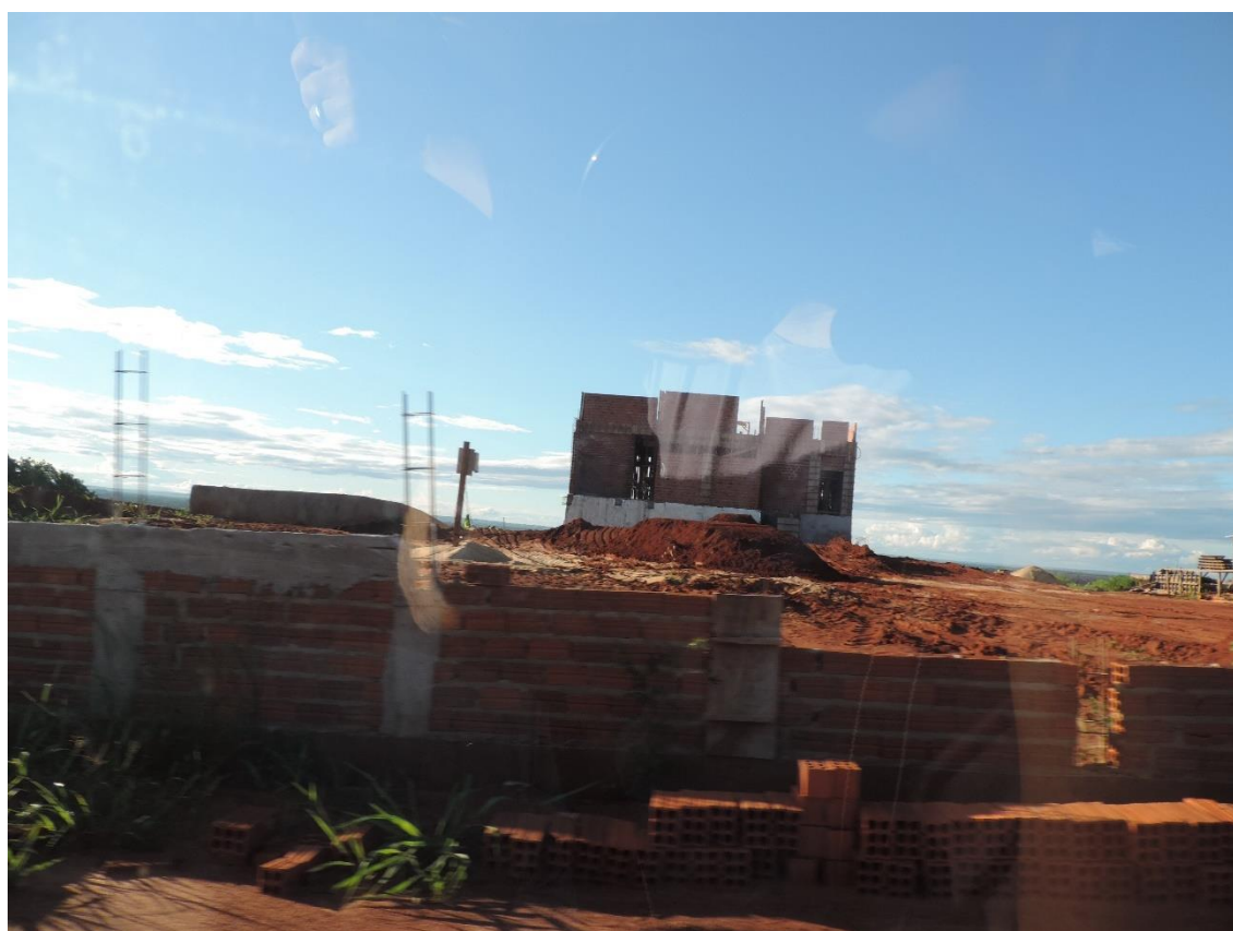
Imagem 25 – Casa em construção.
