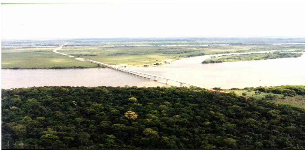
Imagem 6 – Ponte sobre o canal leste
