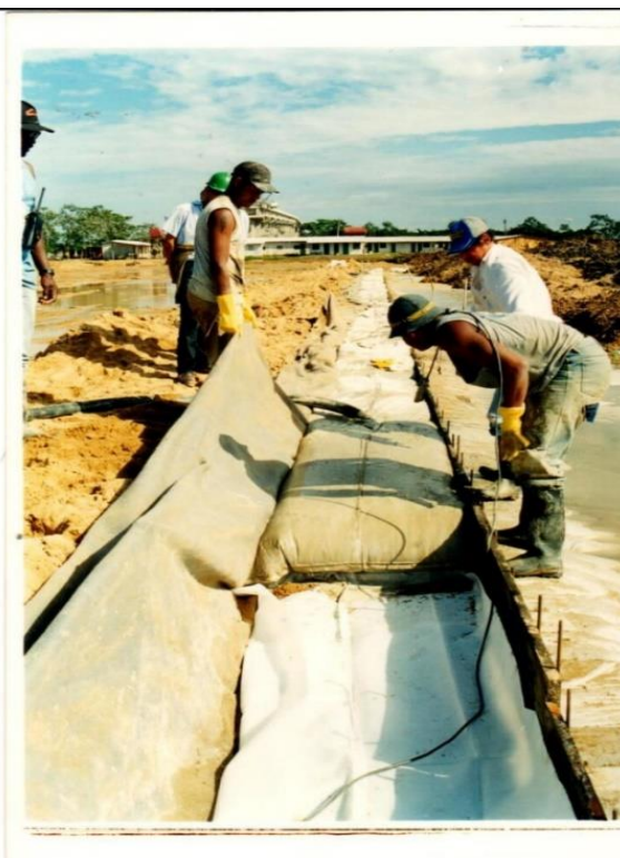
Imagem 20 – Cabeceira canal oeste.
