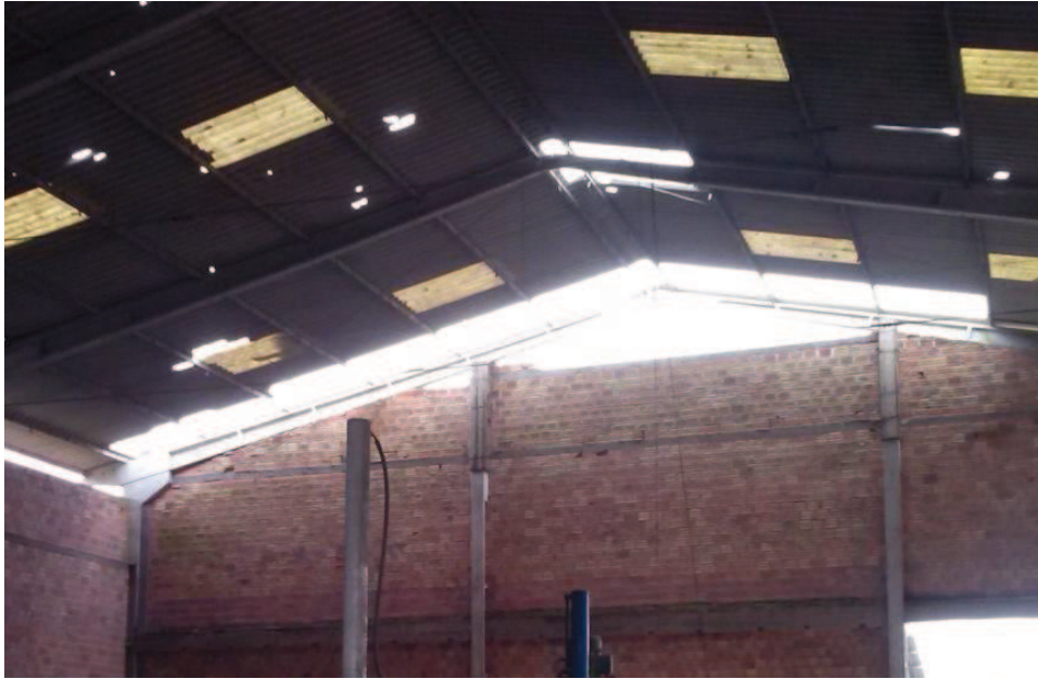
Figura 03 – Teto do barracão com várias perfurações Fonte: acervo da autora
