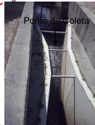
Figura 11. Calha Parshall.
