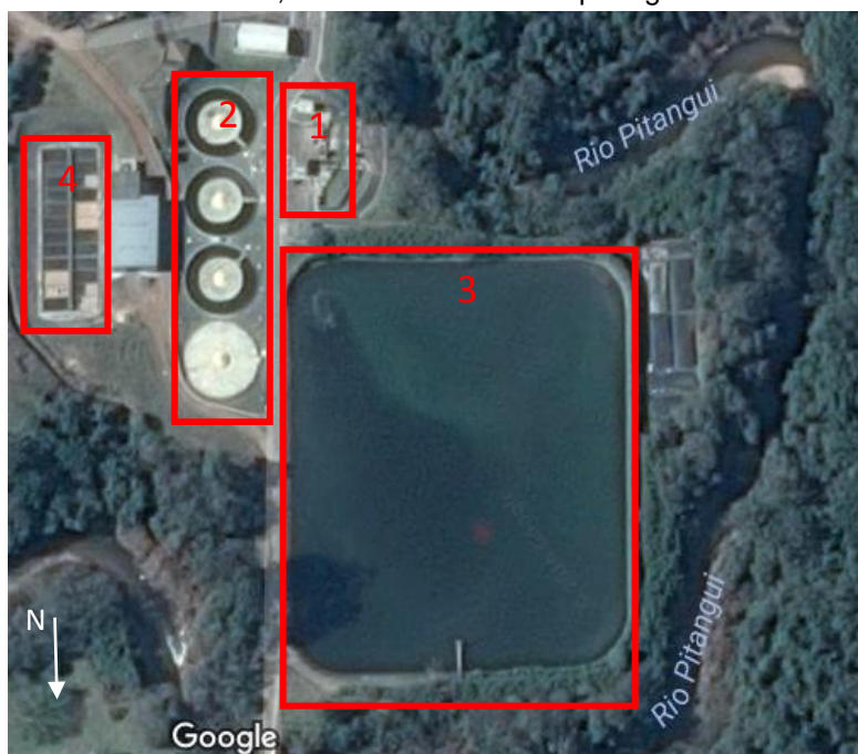
Figura 5. Imagem aérea da ETE Verde, localizada no Jardim Ipiranga.
