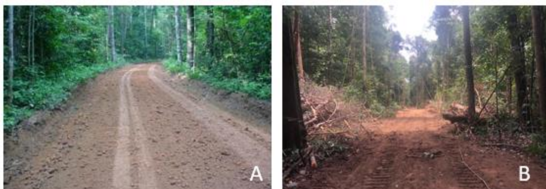
Figura 4. Estradas utilizadas durante o Manejo Florestal, UPA 17 - PA. A: Estrada principal com revestimento de cascalho; B: Estrada secundária.
