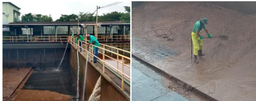
Figura 1 – Limpeza dos decantadores de uma Eta
