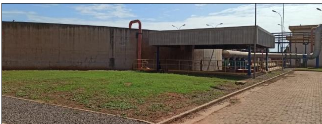
Figura 4.10: Tanque armazenamento água tratada
