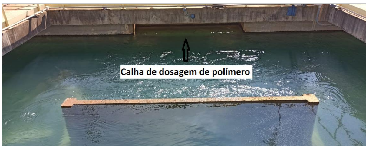
Figura 4.6: Entrada câmara floculação e dosagem de polímero
