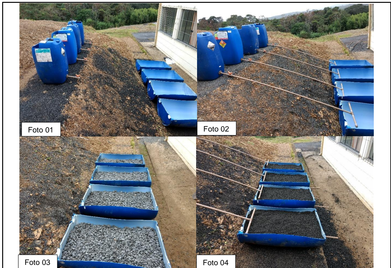
Quadro 03 - Fotos da sequência de montagem dos leitos.
