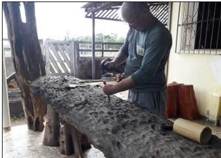
Figura 12: Preparação da base do balcão para fixação do vidro com bambu (fonte: autor).
