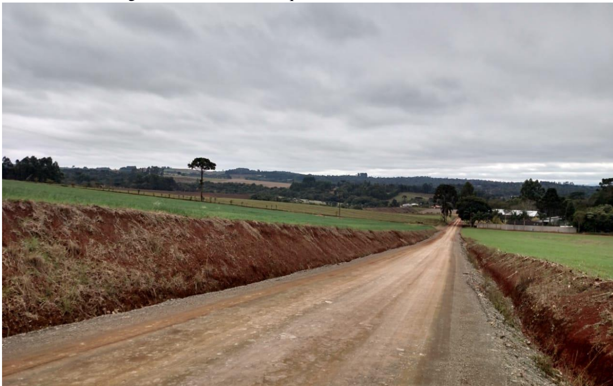
Figura 3: Vista da estrada que leva ao Faxinal Barra Bonita.
