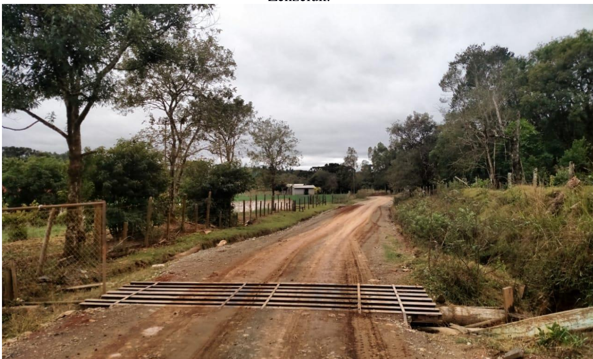
Figura 4: Mata burro na entrada do Faxinal Barra Bonita, próximo à residência de Josafat Zenzeluk.
