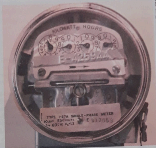
FIGURA 4.51. Medidor de energia elétrica em uma residência.
