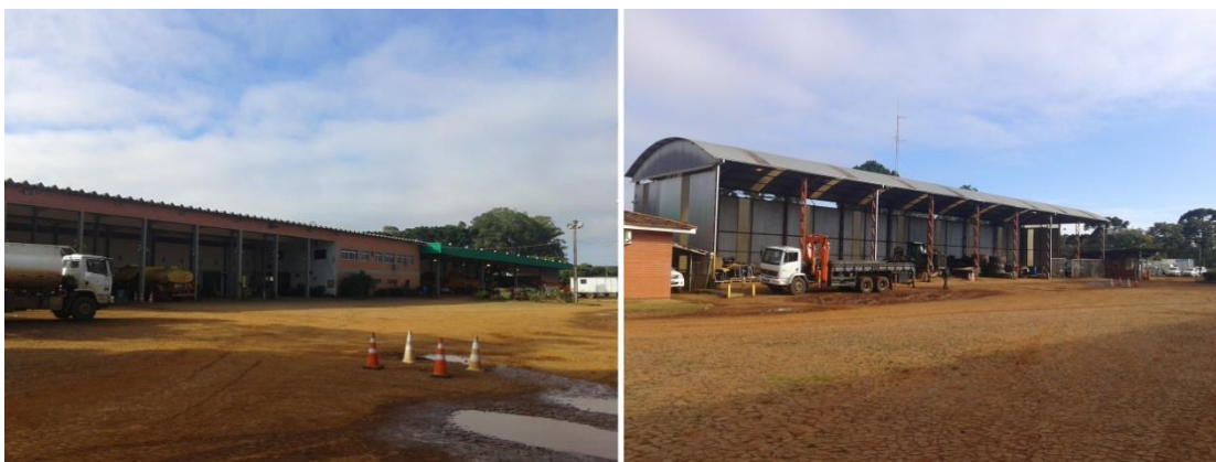
Figura 17. Estrutura da oficina central
